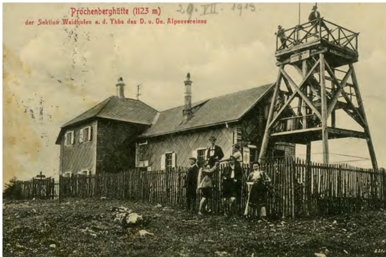
Prochenberghütte: Ansicht von Südosten, Fotografie, 1913
