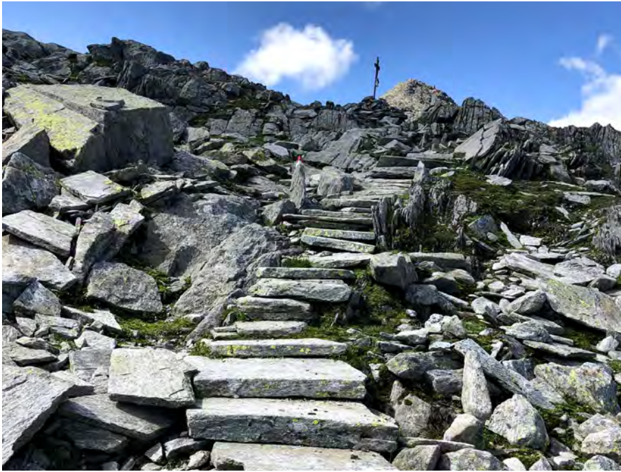
Krimmler Tauernweg: Stufen aus Steinplatten, knapp unterhalb der Passhöhe
