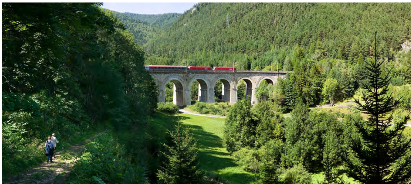
Semmering, Bahnwanderweg beim Viadukt über den unteren Adlitzgraben
